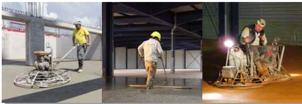
. Surfaçage du dallage
